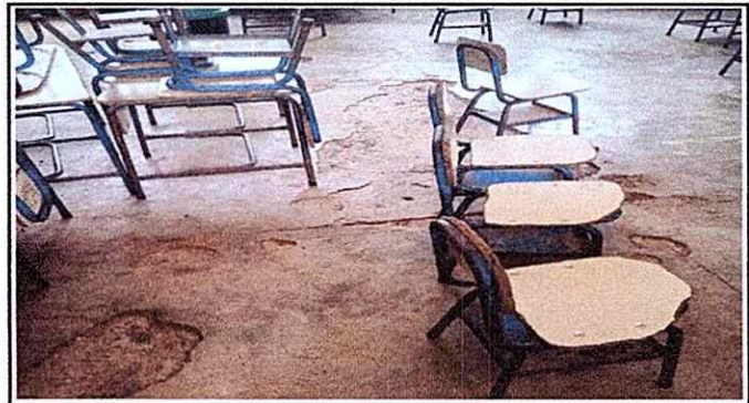
Foto 4: Rehabilitacion de piso de concreto
