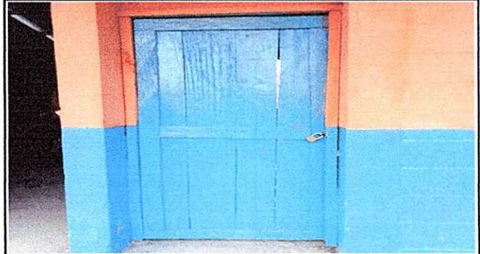
Foto 2: Cambio de puertas del establecimiento
