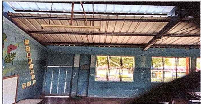
Foto 6: Reparacion de instalacion electrica
