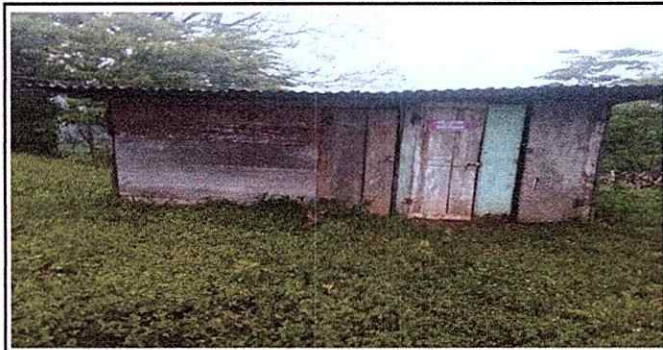
Foto 5: Reparacion de baños
